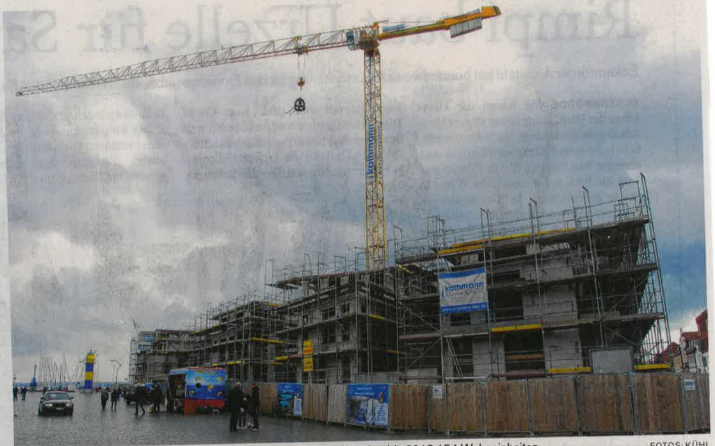
Die Hafenspitze nimmt langsam Konturen an. Insgesamt entstehen dort bis 2018 154 Wohneinheiten.
