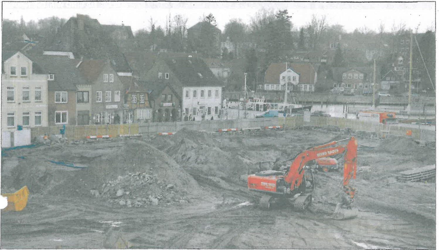
Die Arbeiten für den zweiten Bauabschnitt des Projekts Hafenspitze laufen auch während des Winters weiter. Der Bagger schafft derzeit die Grundlage für ein Fundament, auf dem ein Kran standsicher aufgestellt wird. Fotos Pörksen
