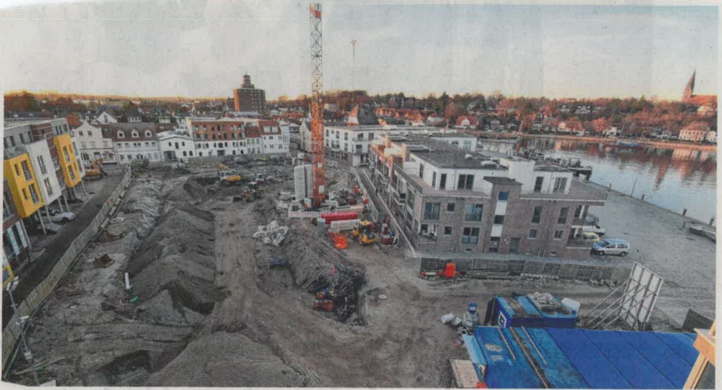
Letzte Großbaustelle an der Hafenspitze: Dort entstehen 40 weitere Wohnungen in zwei Gebäuden sowie sieben Stadthäuser. KÜHL
