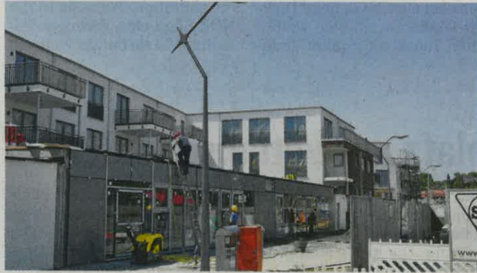
In dem flachen Anbau vor den Hafenwohnungen ziehen eine Bäckerei und der Fischverkauf „Mehrfisch“ ein. FOTOS: CHRISTOPH ROHDE
