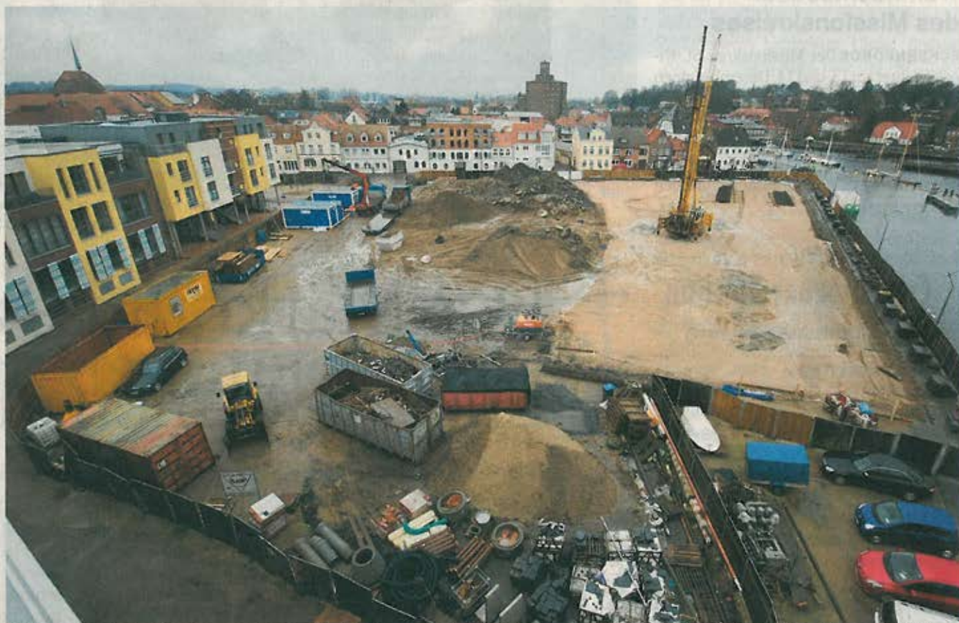
Blick vom Dach des Appartementhauses: Der 70-Tonnen-Bohrer (gelb, oben rechts) erzeugt 15 bis 20 Meter tiefe Löcher, die mit Stahlbeton gefüllt werden. Auf diesen Pfählen wird sich das Fundament der beiden Häuser gründen. PETERS
